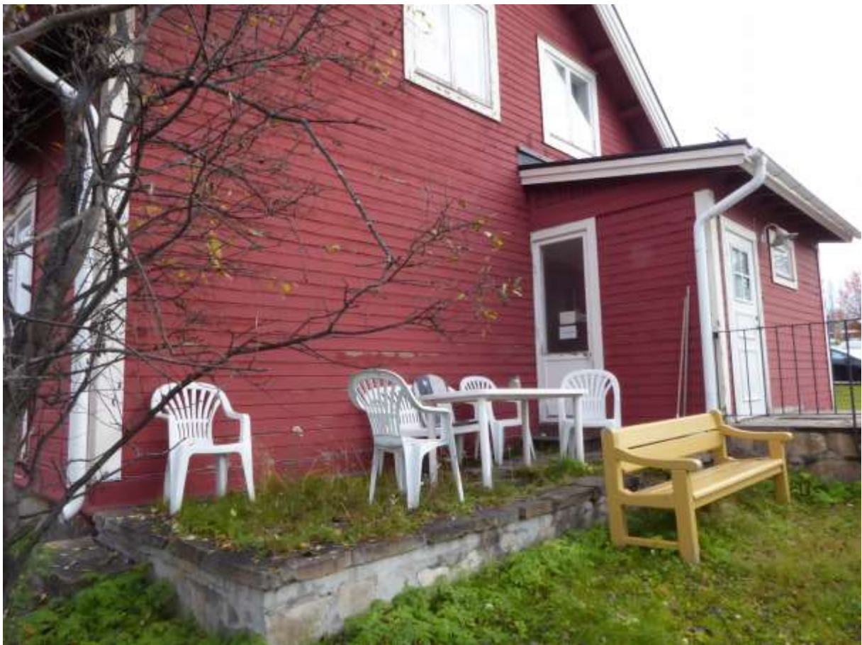
Altan på byggnadens södra gavel.
