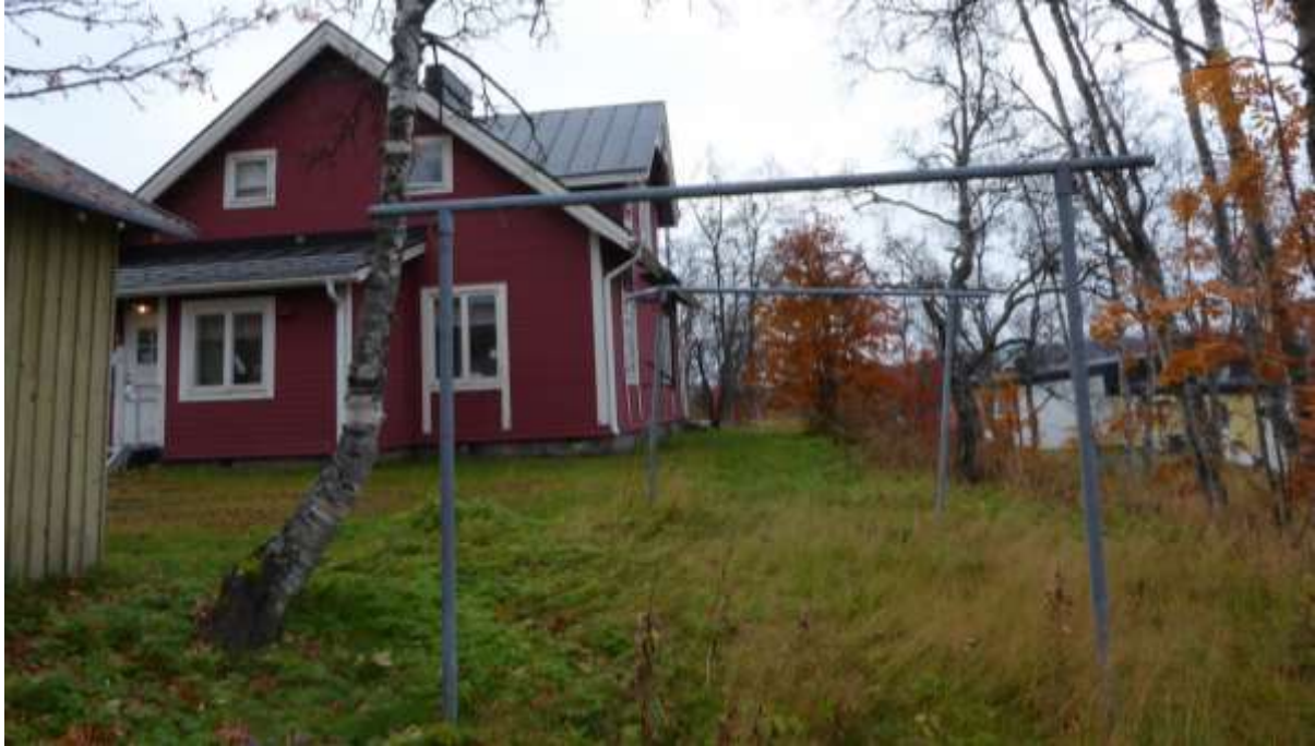
Ställning för torklinor nordväst om byggnaden.
