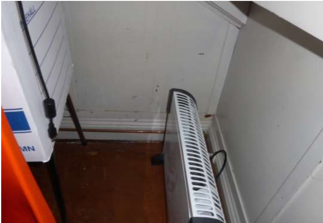
Äldre socklar, lika de i vindsutrymmet, finns också skrubben under trappan på bottenvåningen. Här är emellertid väggarna klädda med masonit.
