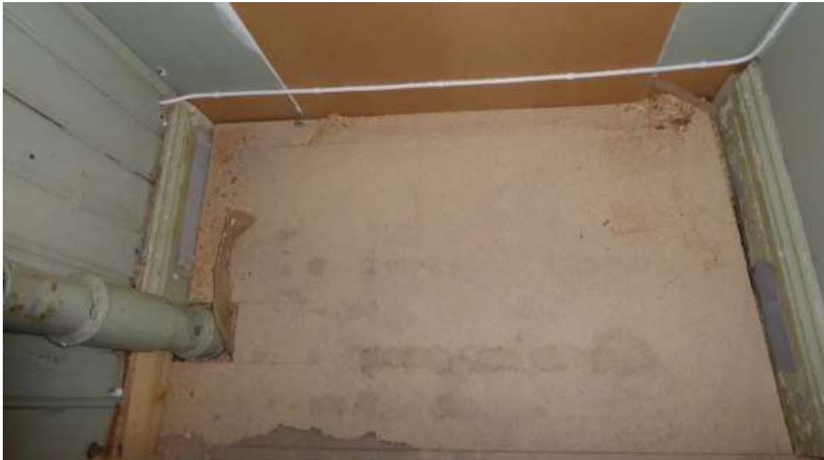
Vindsutrymmet som på ritning från 1910 benämns som "klädskrubb". Pärlspont-panelen är av bredare modell, ca 85 mm, och målad i en tidstypisk kulör.
