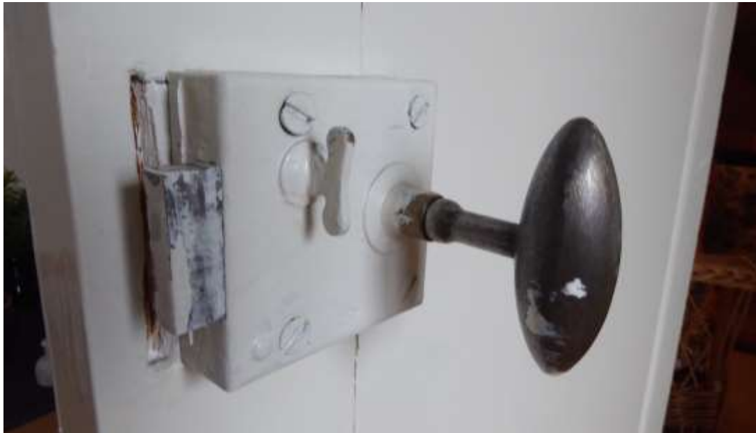
Kammarlåset på dörren till vindsutrymmet.
