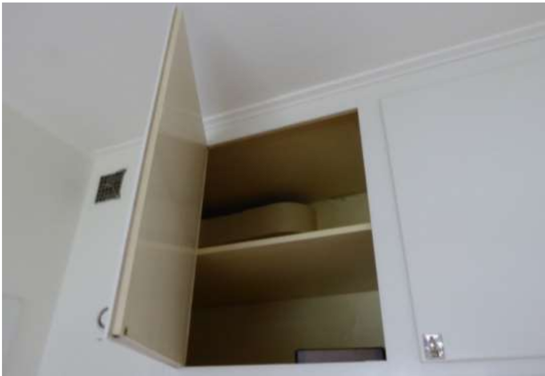
Överskåp tillhörande garderober på övervåningen, tillkomna under tidigt 1950-tal. Luckorna har förnicklade stängningsbeslag. Skåpinredningen är målad med en vit oljefärg som i det mörka utrymmet gulnat med åren.
