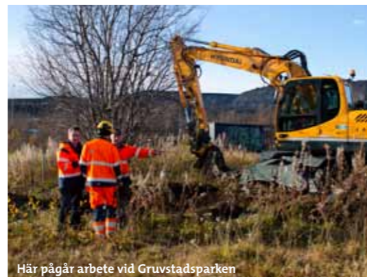
Här pågår arbete vid Gruvstadsparken
