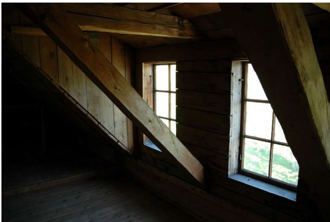
Ursprungliga fönsterbågar i takfall mot öster.
