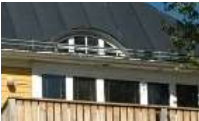
T v: De små lunettfönstren på gavlarna har idag förvunnit bakom balkong och snörasskydd men utgör en viktig ursprunglig detalj. T h: Underliggande färgskikt. Foder var tidigare något gråare till kulören. Den ockragula fasadkulören var tidigare mer mättad i tonen.
