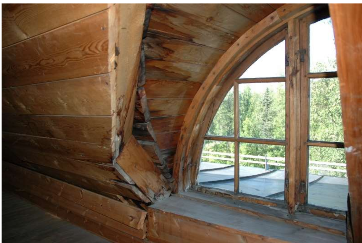
Ursprungliga lunettfönster på gavlarna.
