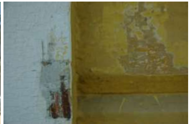
T v: De små lunettfönstren på gavlarna har idag förvunnit bakom balkong och snörasskydd men utgör en viktig ursprunglig detalj. T h: Underliggande färgskikt. Foder var tidigare något gråare till kulören. Den ockragula fasadkulören var tidigare mer mättad i tonen.
