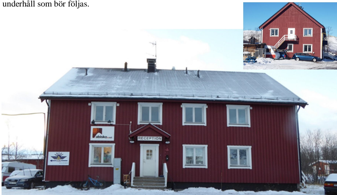
Bild 29-30 Abisko Fjällturernas huvudbyggnad (foto: Clara Nyström) och byggnadens gavel.
