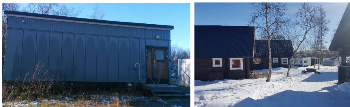
Bild 33-34 Kommunens vattenverk är mitt i detaljplanområdet (vänster). Verksamhet flyttas möjligen i framtiden. Byggnaden och omgivningen ser ovårdad ut. Mountain Lodges stugor (höger) i anslutningen till detaljplanområdet.
