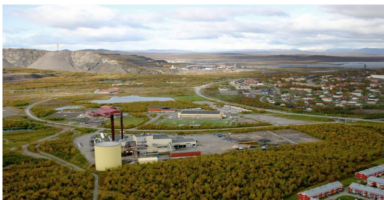
Värmeverket i Kiruna. Foto: Mats Nilsson, Kiruna kommun
